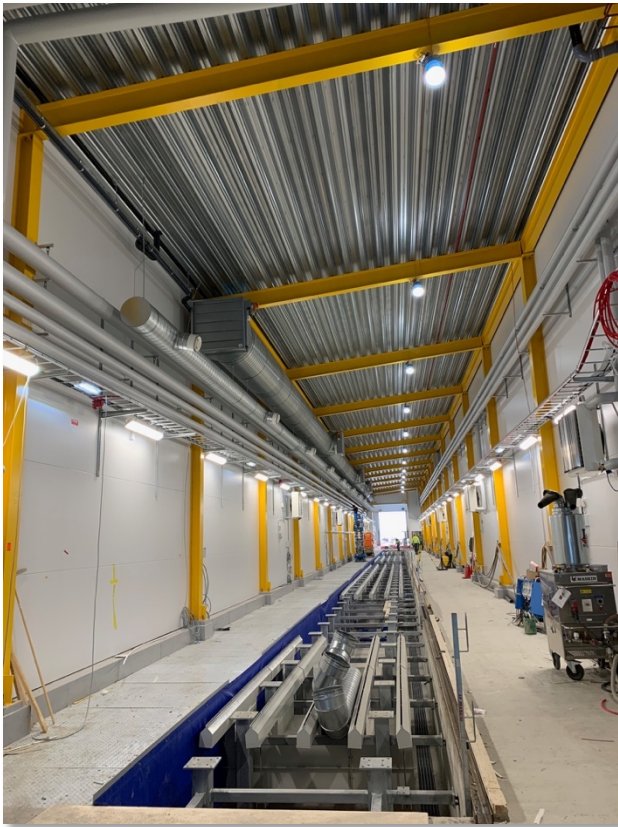
Multifunktionshallen är nu färdigbyggd och kommer att tas i bruk i juni.
