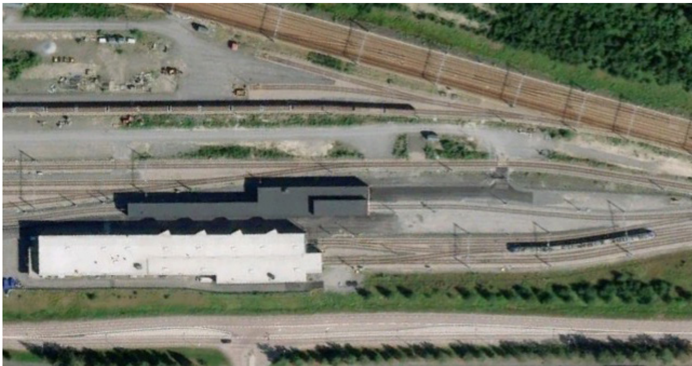
Verkstadsdepå i Umeå. Umeådepån är hjärtat i Norrtågstrafiken, där merparten av fordonen underhålls förebyggande eller avhjälpande. Depån har två reparationsspår. Den gamla hallen (vit) och en ny hall (grå) för avisning, hjulsvarv samt tvätt. Depån är förberedd för expansion.
